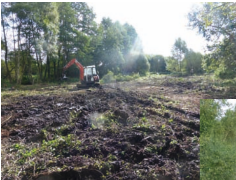
Une mini-pelle chenillée a permis de transporter les végétaux jusqu'au broyeur de branches.
