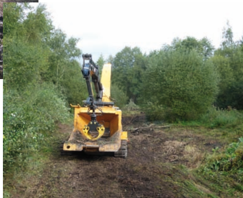
Les branches ont ensuite été broyées et évacuées du site
