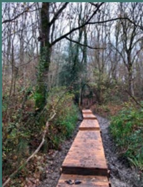
Création d'un platelage sur le Communal de Sorrus (62)
