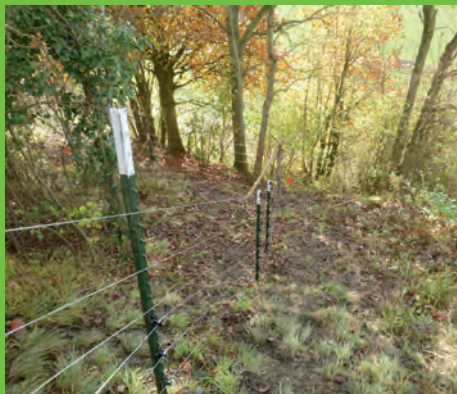
Pose de clôtures à Grouches-Luchuel
