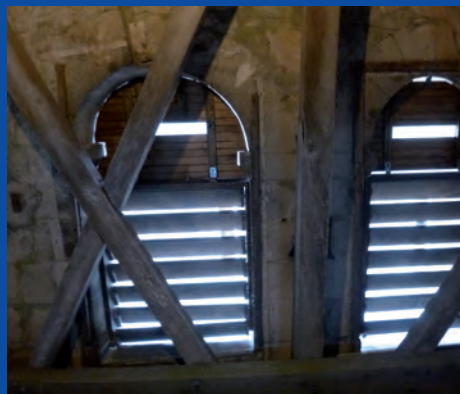
Aménagement de l'église de Coyolles
