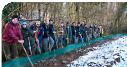
Installation d'une barrière temporaire à amphibiens à Ligny-sur-Canche (62)
