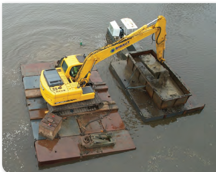
Curage par une pelle sur flotteur © J. HUMMEL
