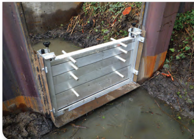
Pose d'un seuil © G. RIVIÈRE
