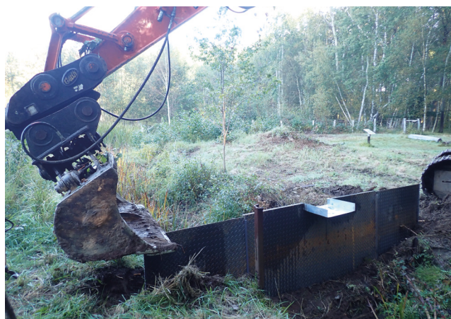
Pose du seuil de la mare à Zouzou
