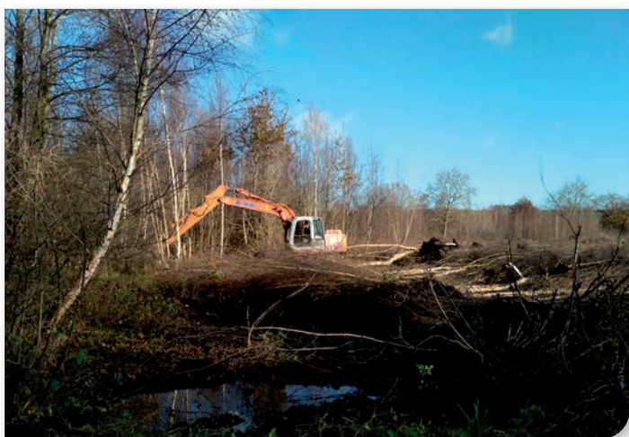
Travaux de déboisement et essouchage à Long (80) © Raoul DAUBRESSE
