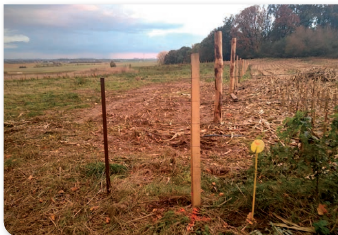
Pose de nouvelles clôtures © A. THÉRY
