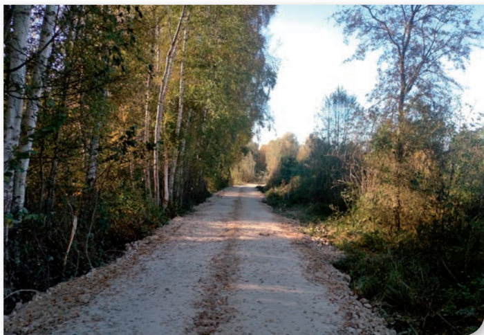
Création d'un accès technique à Long (80) © J. HUMMEL
