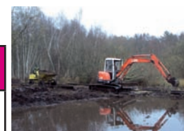
2011 Restauration de la mare
