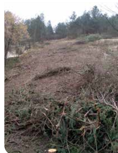
Travaux de restauration Saint-Pierre-ès-Champs © CEN
