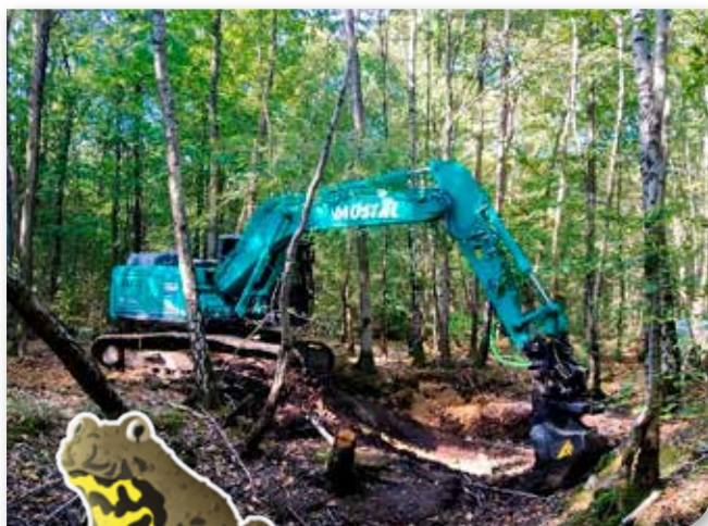
Travaux de restauration de mare © F. WEITZEL
