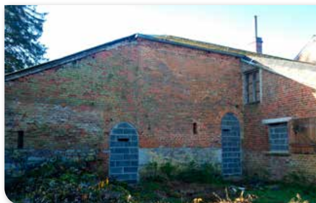
Travaux d'obstructions partielles des différentes entrées et fenêtres pour les chiroptères • Nord
