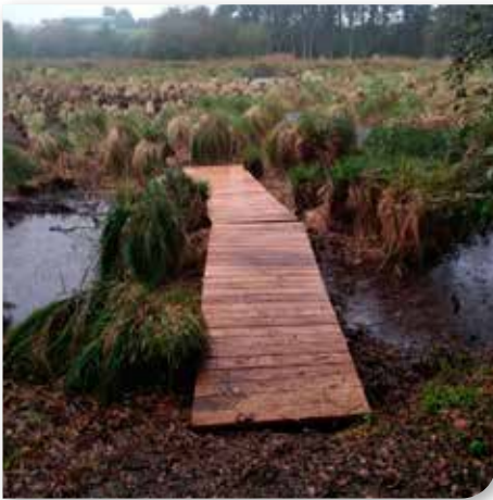
Étapes de création d'une passerelle Marais du Warnier • Pas-de-Calais © A. VASSEUX
