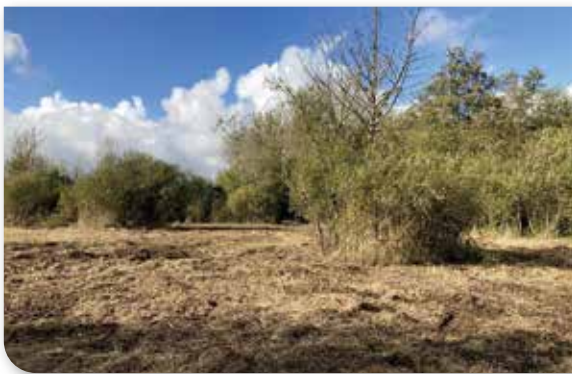
Travaux de débroussaillage - Marais du Haut-Pont à Douriez Pas-de-Calais © CEN
