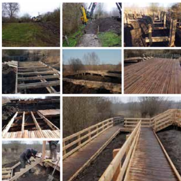
Étapes de réalisation de la plateforme d'observation de l'Étang Saint-Ladre • Somme © CEN
