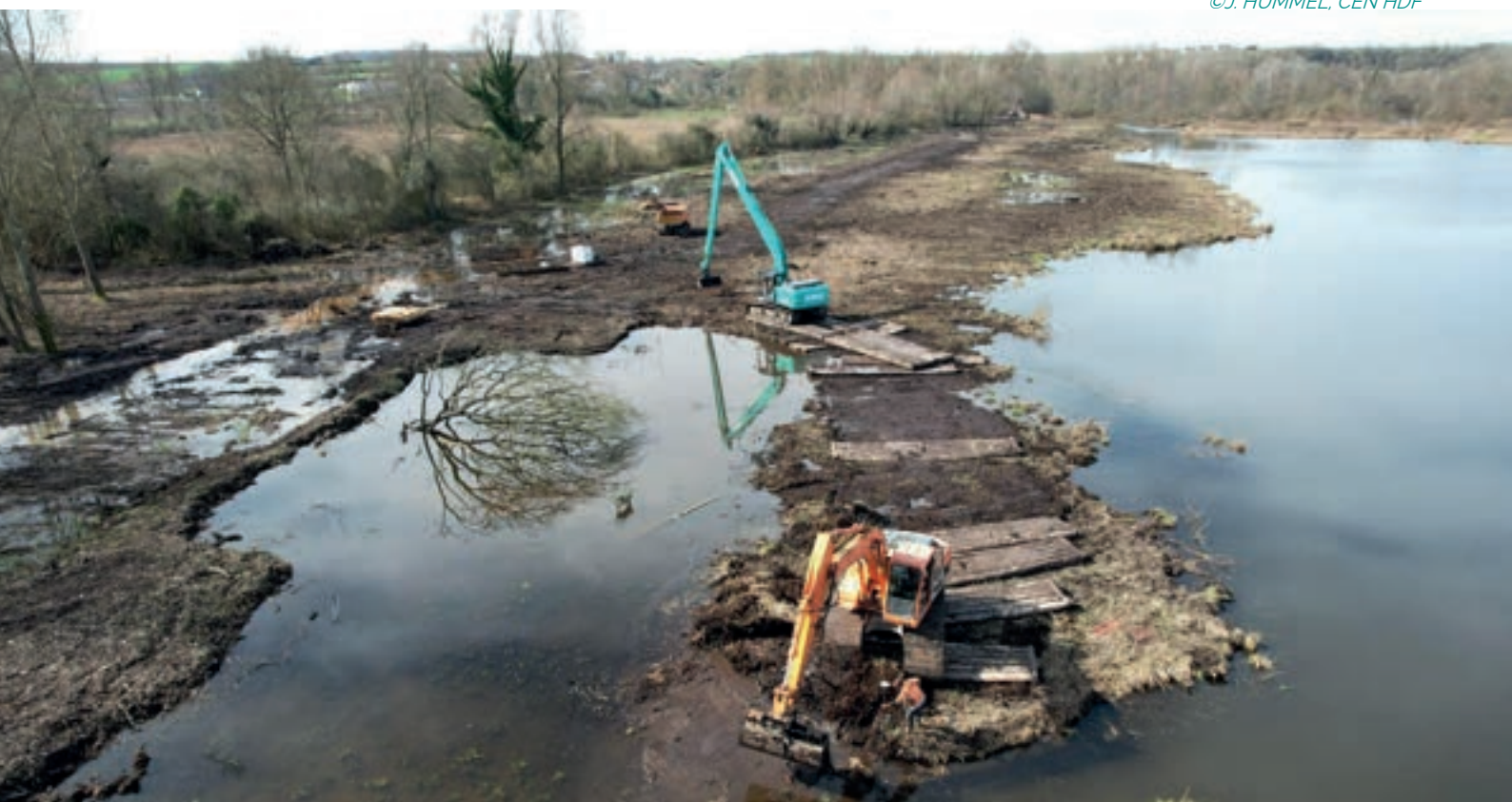
Étrepage à Morcourt. La faible portance des sols de tourbière nécessitent l'utilisation de plaques de répartition de charge pour la circulation des engins de chantier ©J. HUMMEL, CEN HDF
