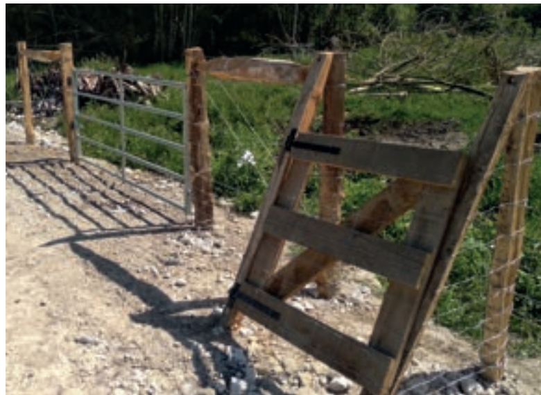
Installation de clôture avec barrière tubulaire et passes-clôtures à Long ©J. HUMMEL, CEN HDF
