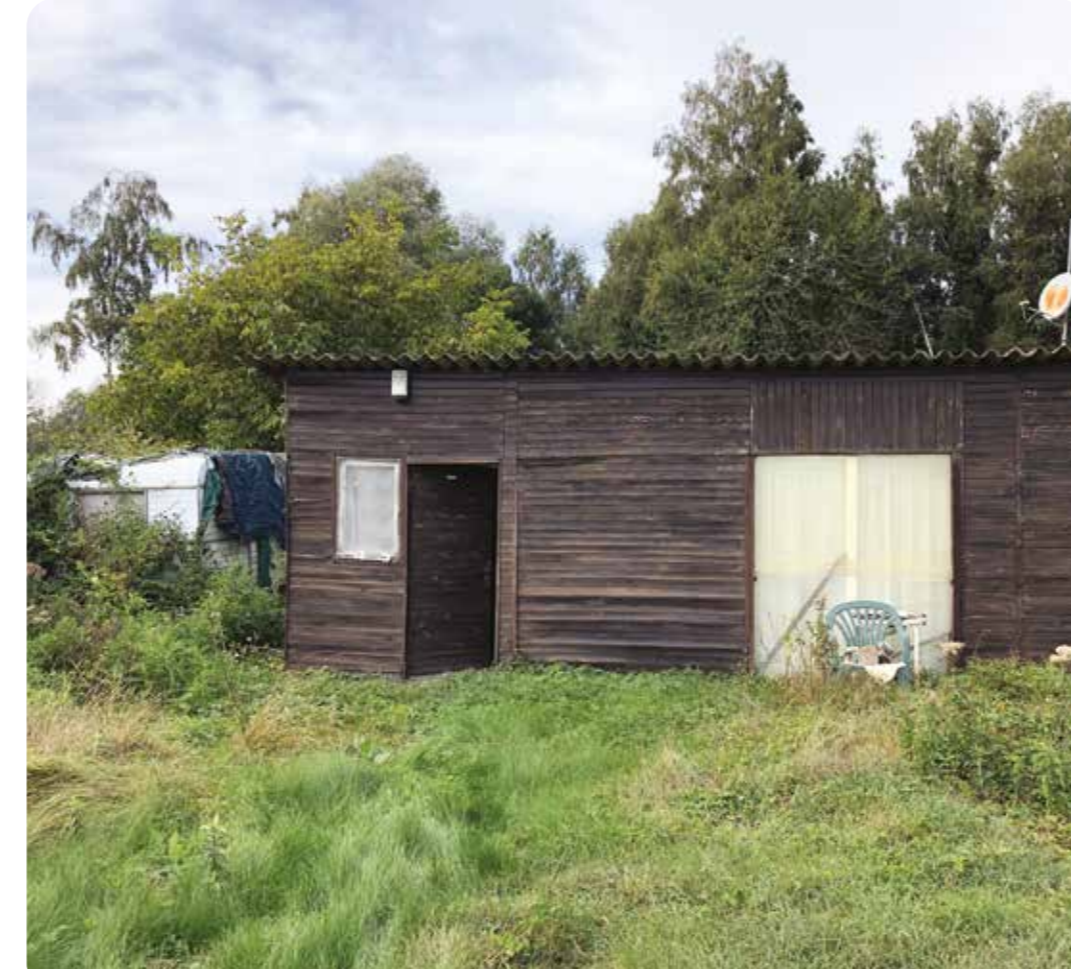
Démantèlement et évacuation d'un ancien cabanon.
