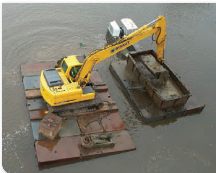
Curage par une pelle sur flotteur © J. HUMMEL
