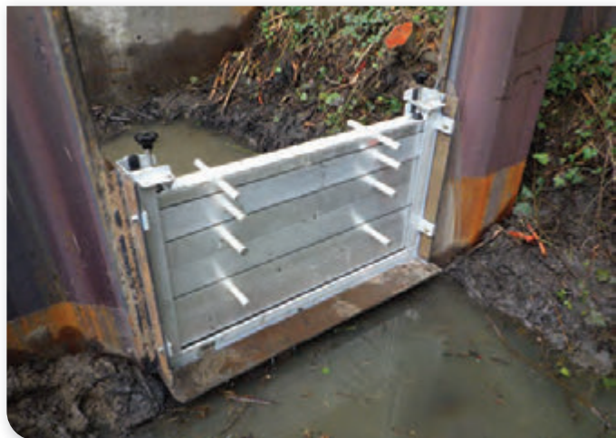
Pose d'un seuil © G. RIVIÈRE
