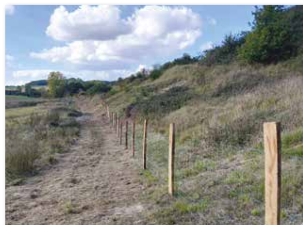
Pose des clôtures © S. BEZILLE
