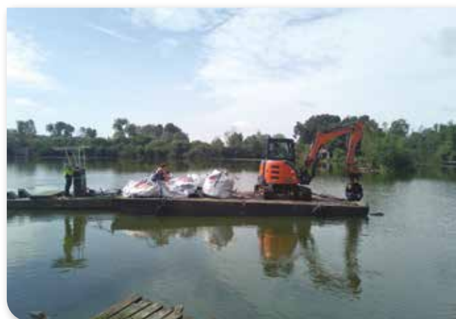
Évacuation des matériaux par voie d'eau © A. ANDRÉ
