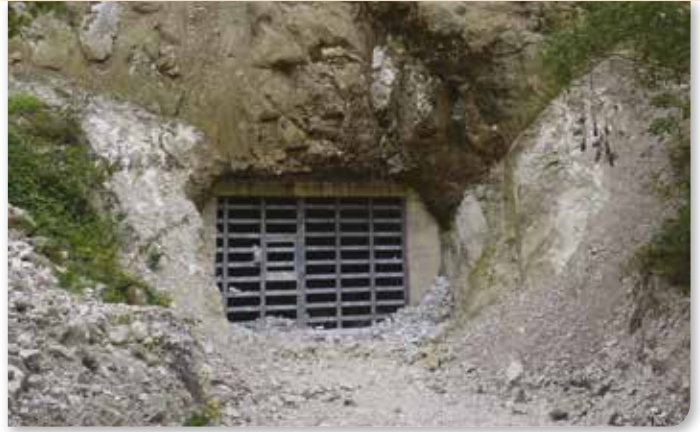
Entrée d'une cavité © D. ADAM
