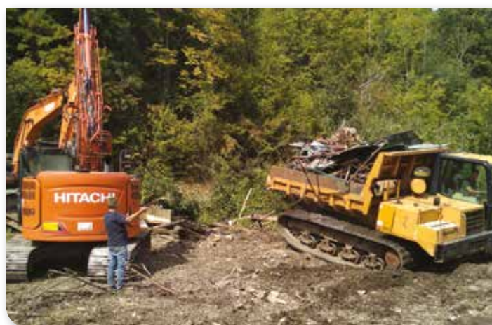
Pelle chenillée et dumper sur le chantier de dépollution © A. ANDRÉ
