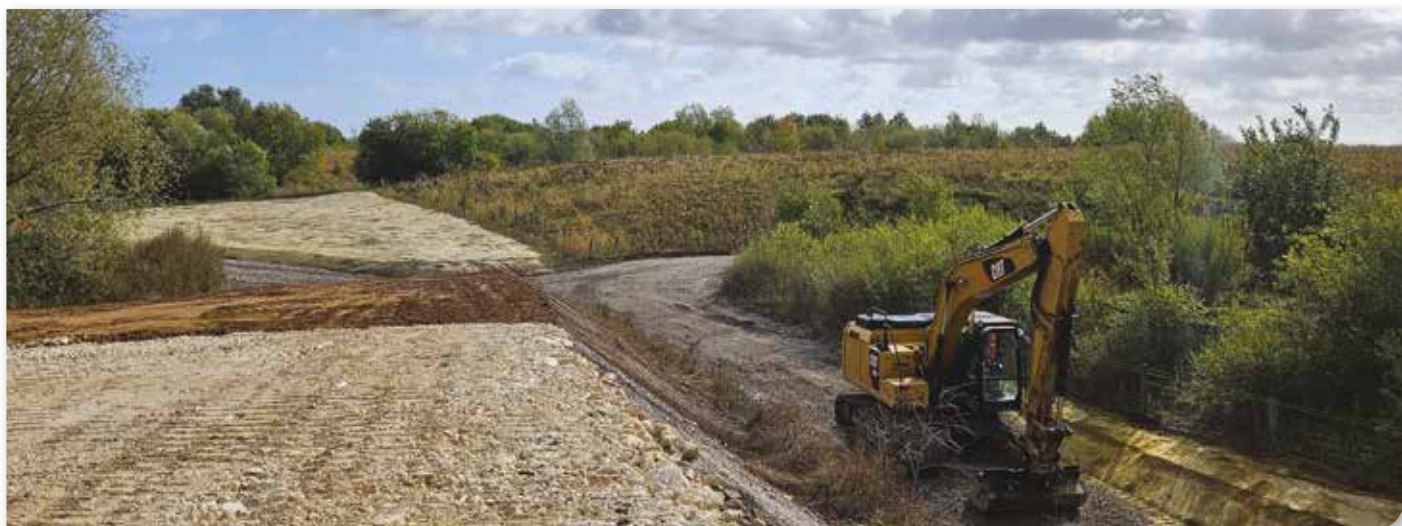
Travaux de réhabilitation de la Sablière d'Hamel © F. CHEMIN
